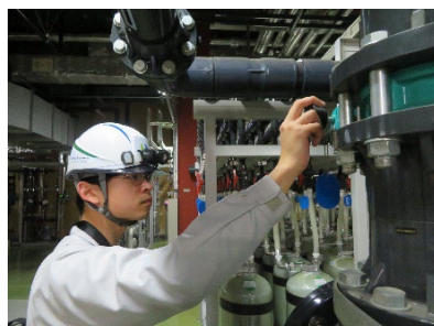
動力室保守点検作業者の様子
