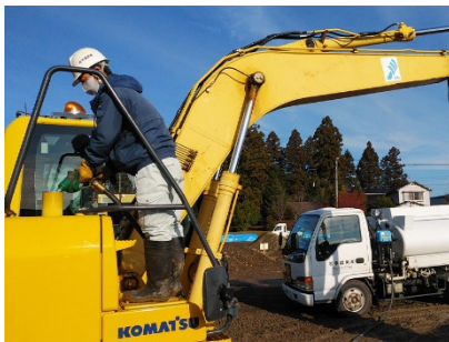
重機へ軽油を給油
