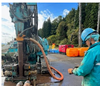
ボーリングマシンによる掘削
