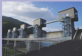
15.5m 東北一の高さを誇る普代水門
