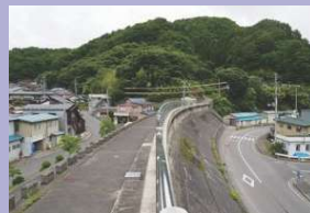
15.5mの太田名部防潮堤
