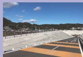
新設された防潮堤 (高さ14.7m)
