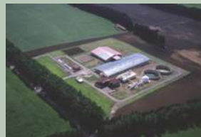
バイオマス発電施設
