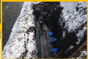
護岸の基礎ブロックの施工状況
