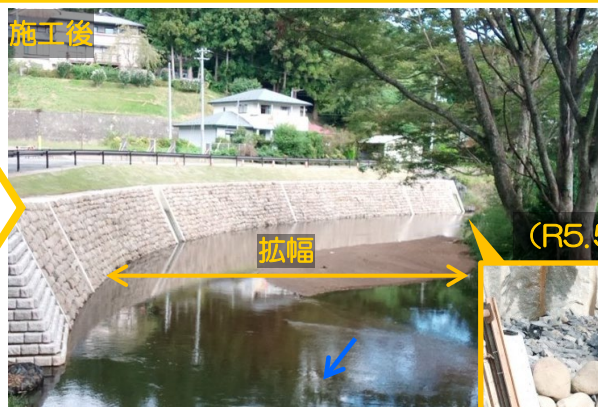
護岸ブロックの施工状況
