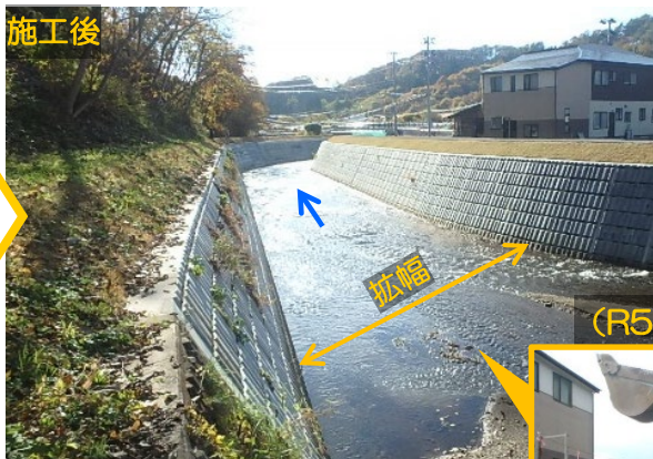
護岸ブロックの施工状況
