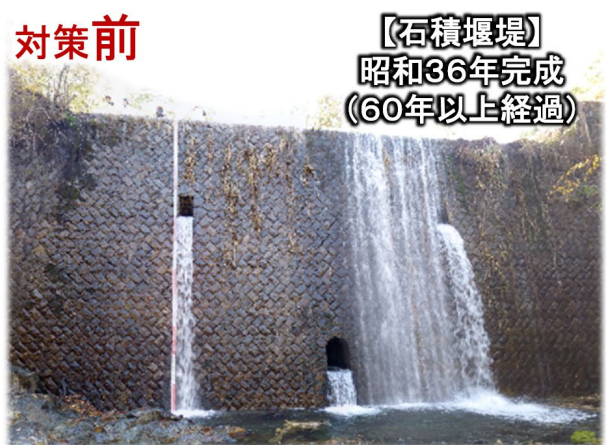
【石積堰堤】 昭和8年完成 （約90年経過）
