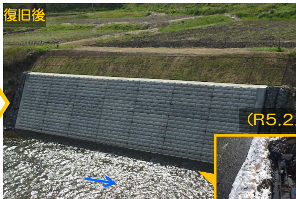
護岸の基礎ブロックの施工状況
