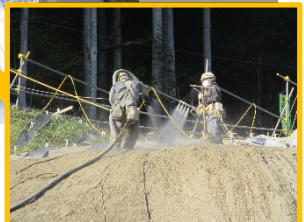
斜面を保護するための吹き付けを行っている状況
