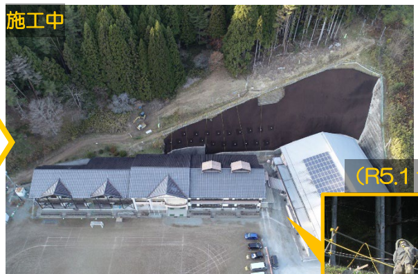
斜面を保護するための吹き付けを行っている状況
