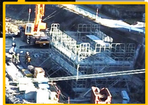
橋を支える橋台(きょうだい)の施工状況
