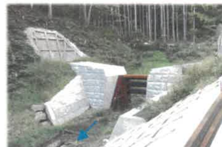
◆見学した「平井賀の沢」砂防堰堤
