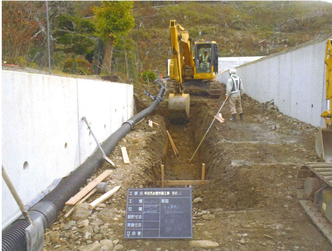
【管路布設前写真】
