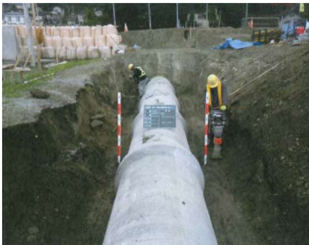
【管路布設完了写真】
