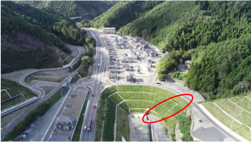
(復旧後 2、避難階段設置前)
