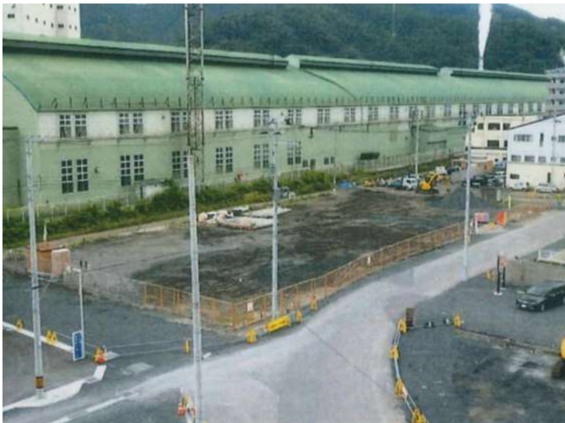
【着手前写真】（汐立雨水ポンプ場）
