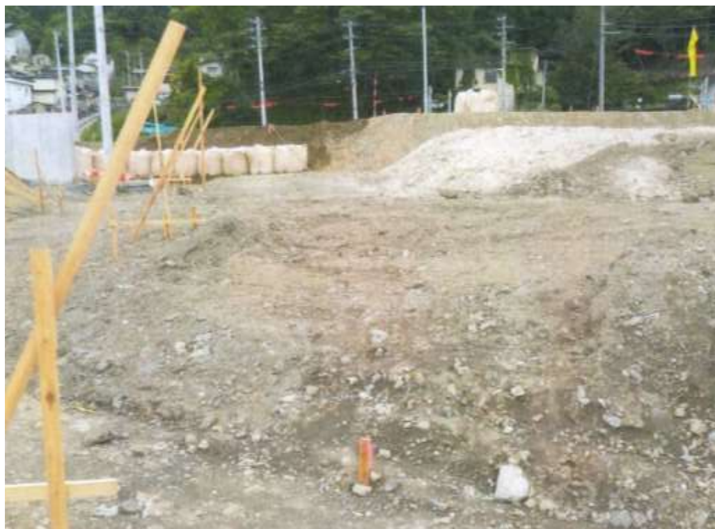
【管路布設前写真】
