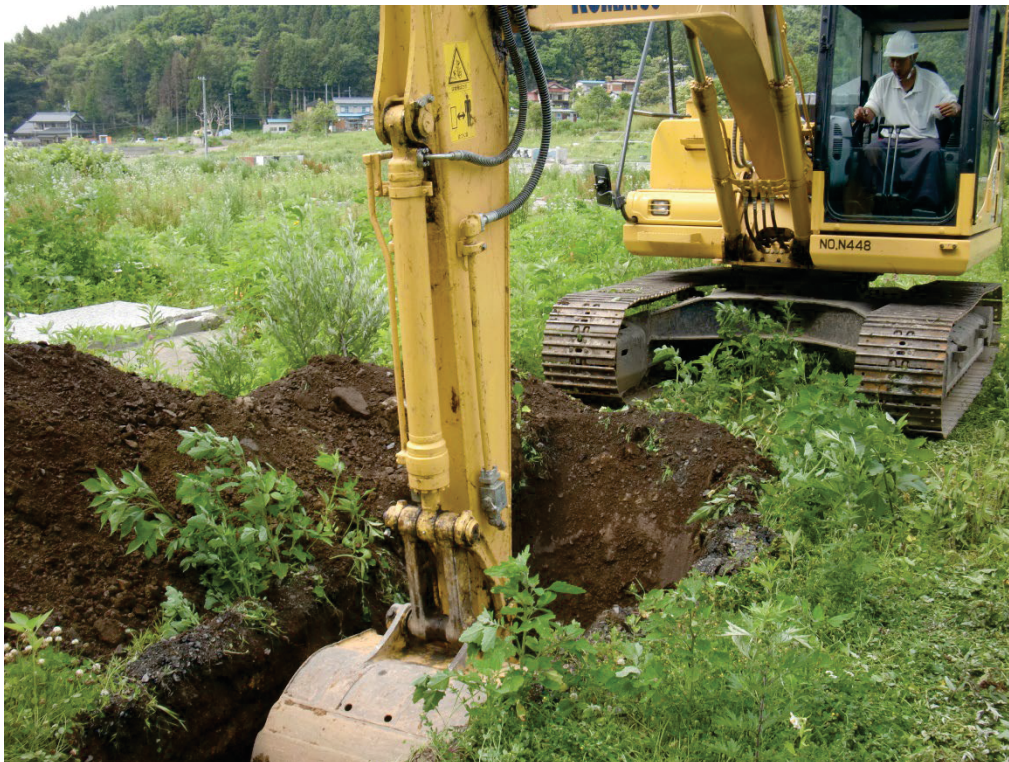
【箱崎地区（市町村支援） 調査風景】
