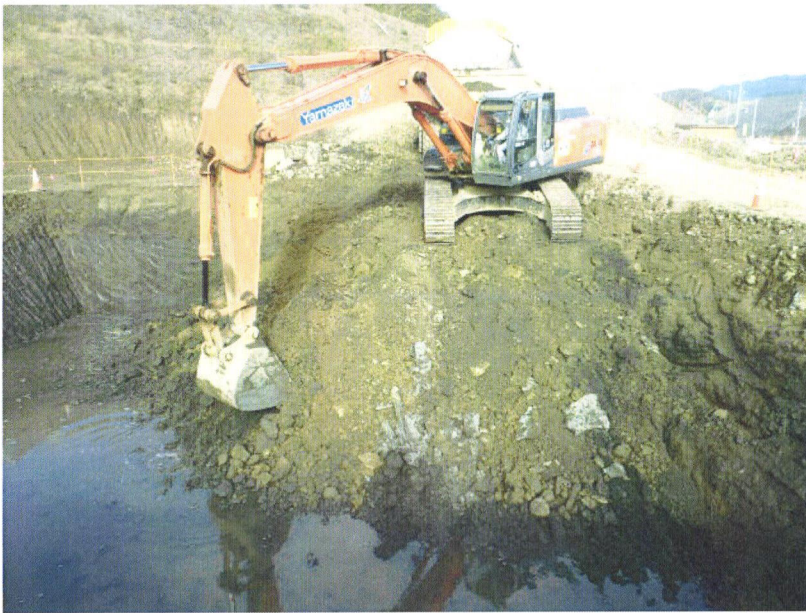
【今泉 改良体撤去工】 三本松 BC10 P4 撤去状況
