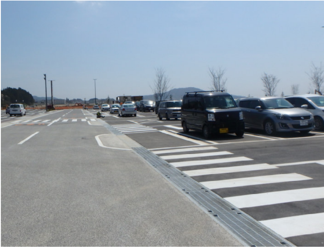
公共駐車場完成写真 ↑
