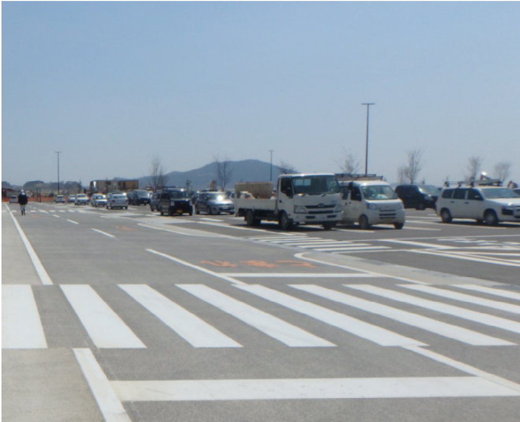
公共駐車場完成写真 ↑
