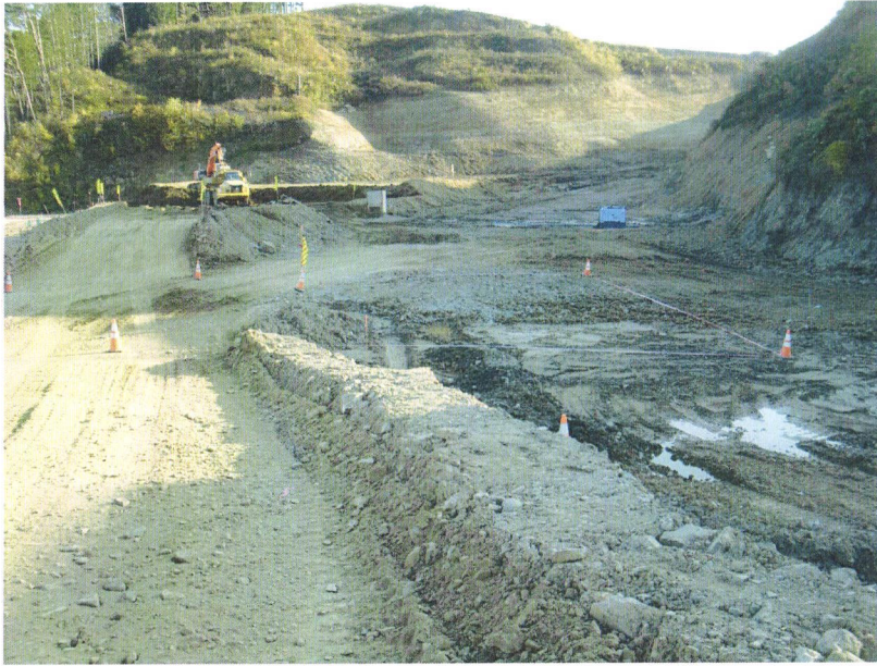
【今泉 改良体撤去工】 三本松 BC10 P4 着工前
