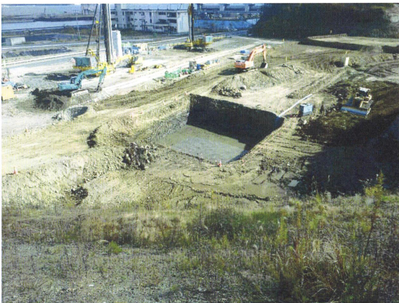
【今泉 改良体撤去工】 三本松 BC10 P4 撤去完了
