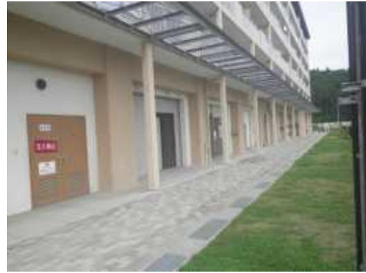
テナント（下和野地区）
