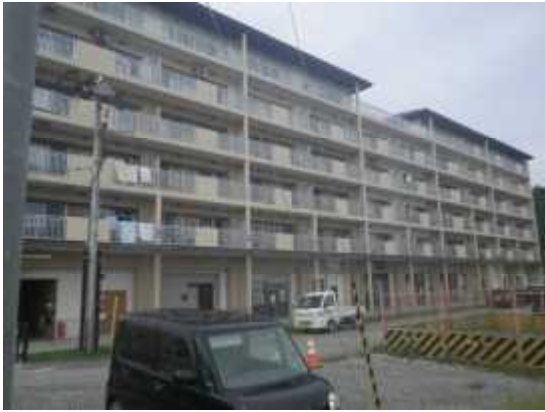
建物全景（下和野地区）
