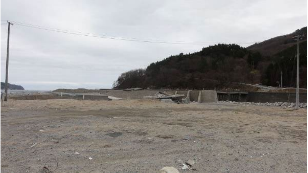
【整備前の被災状況】
