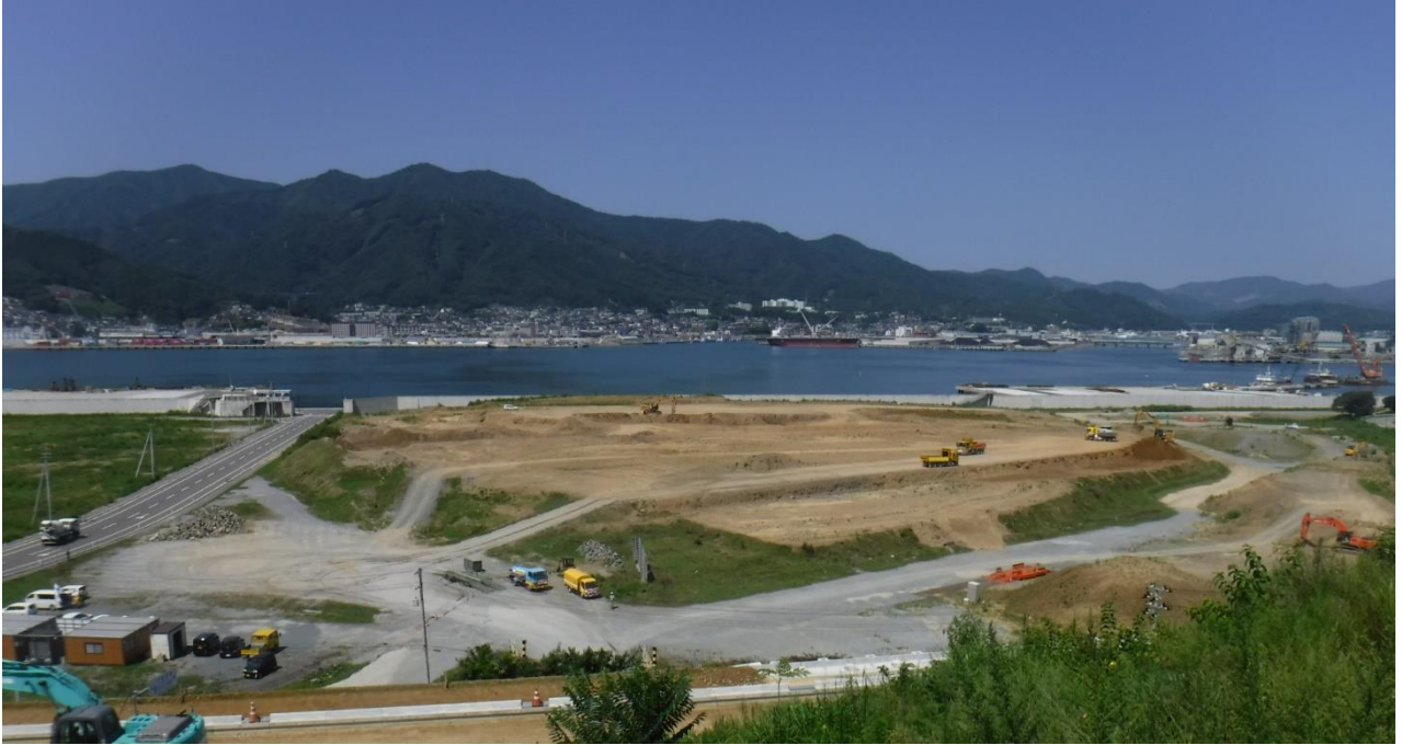
【仮置き場全景（着工前）】
