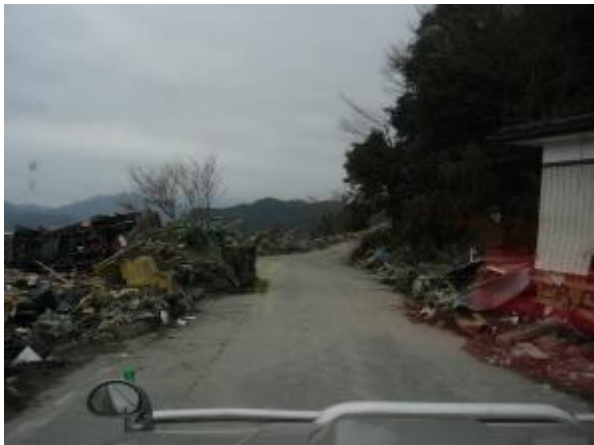
【整備前の旧県道の被災状況】
