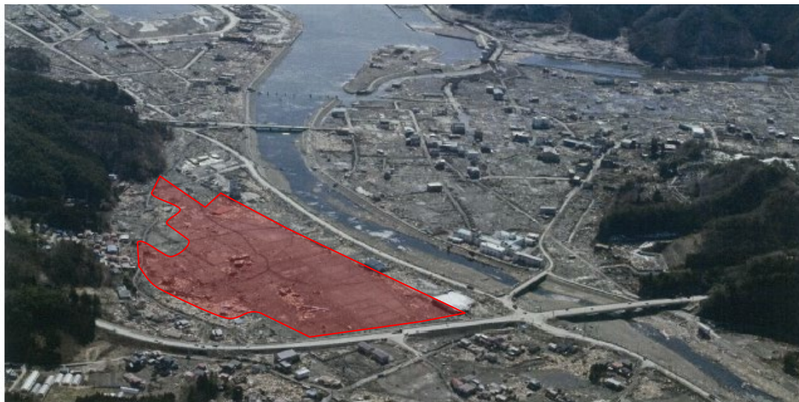
【整備前の被災状況】
