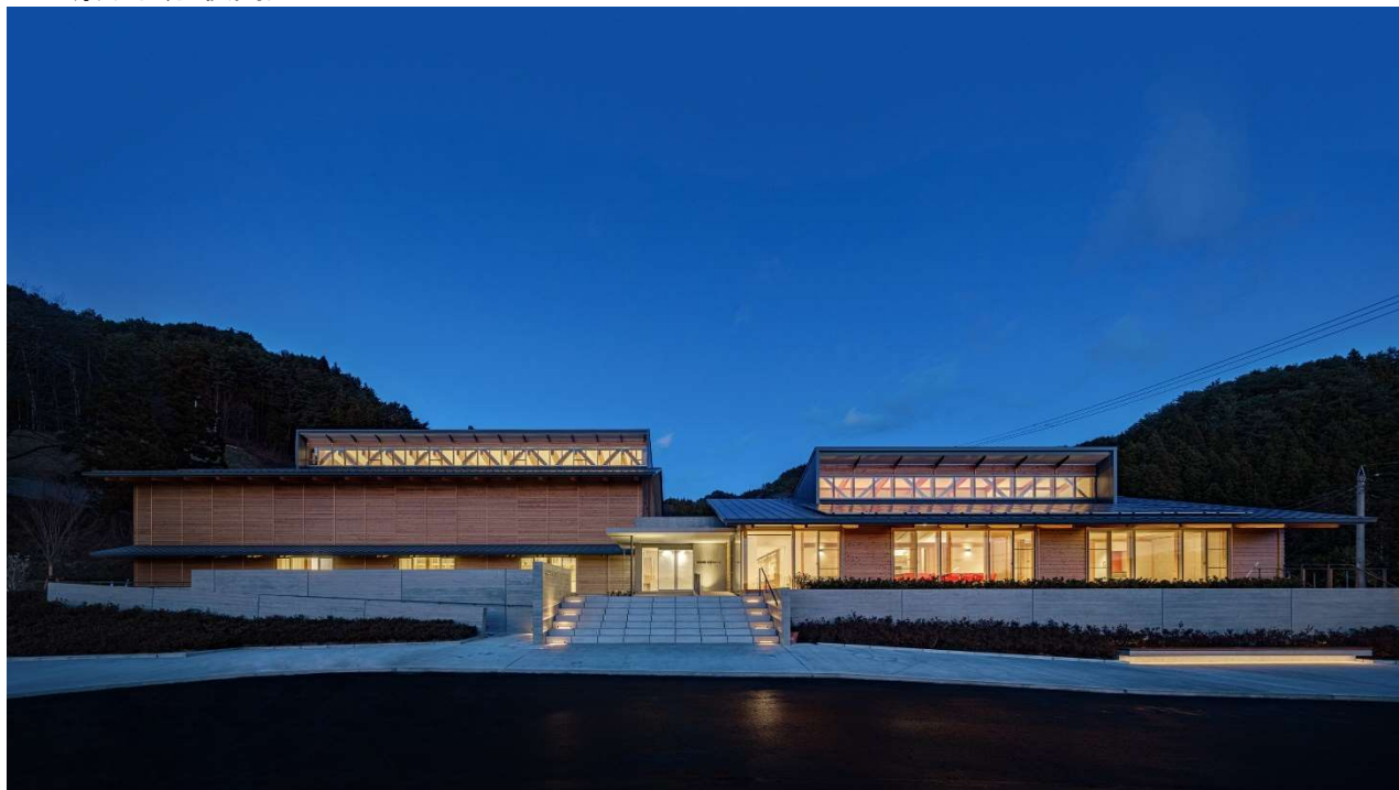
○全景(外観・夜間)
