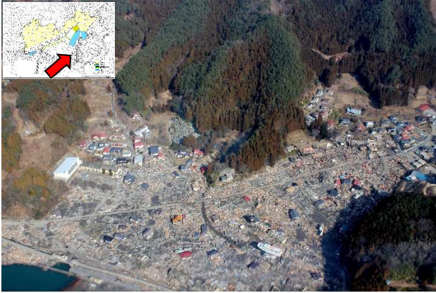
■整備前（被災時）の状況（H23. 3. 14 撮影）
