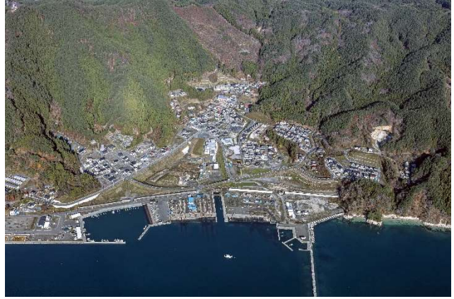
■整備後の状況（H29.11.26 撮影）
