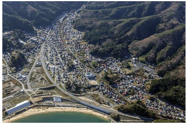
■整備後の状況（H29. 11. 26 撮影）
