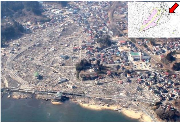
■整備前（被災時）の状況（H23. 3. 14 撮影）
