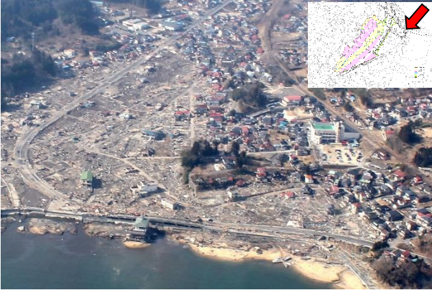
■整備前（被災時）の状況（H23. 3. 14 撮影）
