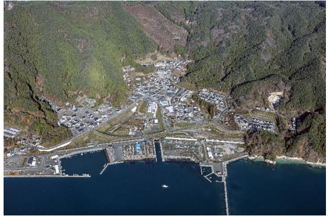
■整備後の状況（H29.11.26 撮影）
