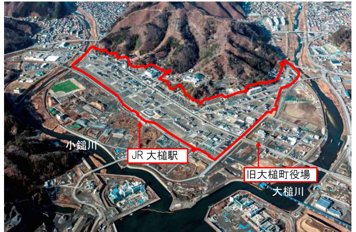
町方地区土地区画整理事業の整備工事完了
