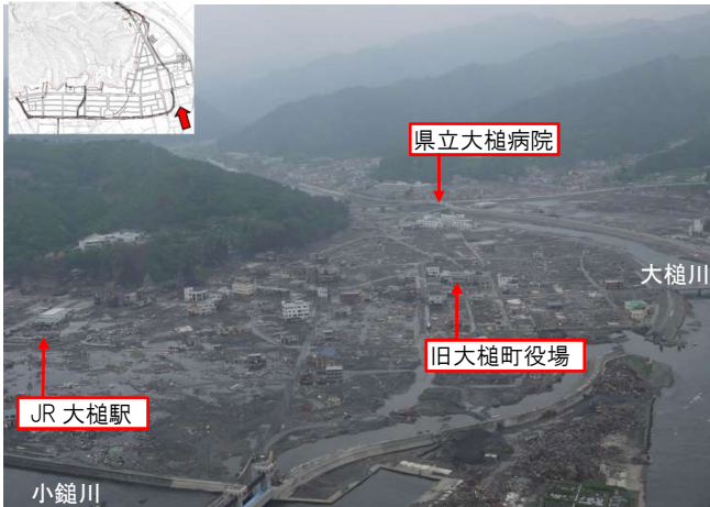
被災した町方地区【町の中心地は、役場も含め壊滅的被害を受けた。】
