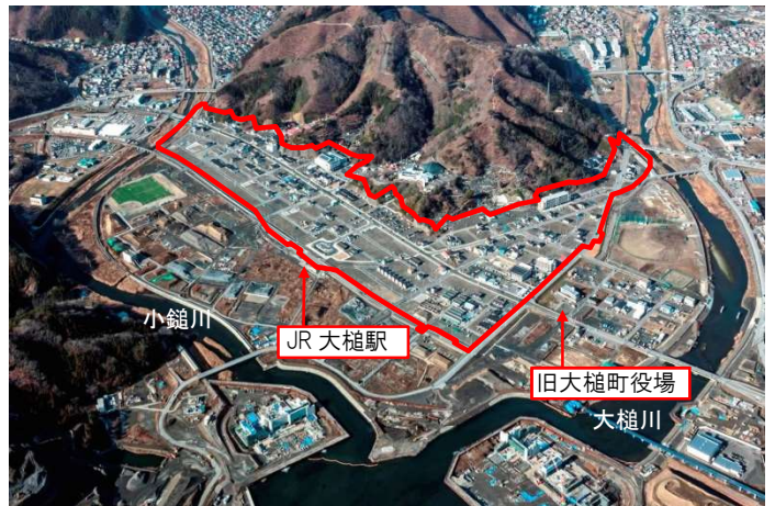
町方地区土地区画整理事業の整備工事了
