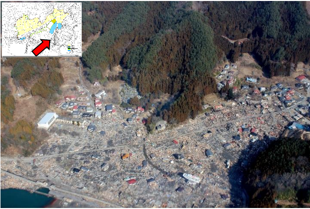
■整備前（被災時）の状況（H23. 3. 14 撮影）
