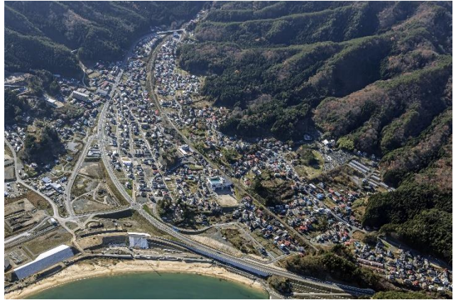
■整備後の状況（H29. 11. 26 撮影）
