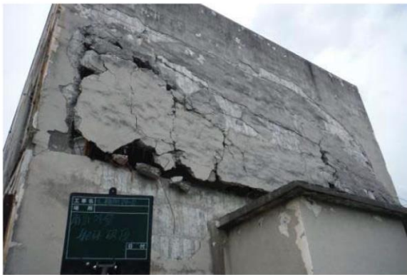
2階壁破損
