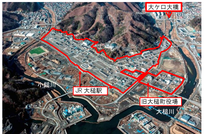
町方地区土地区画整理事業の整備工事完了
