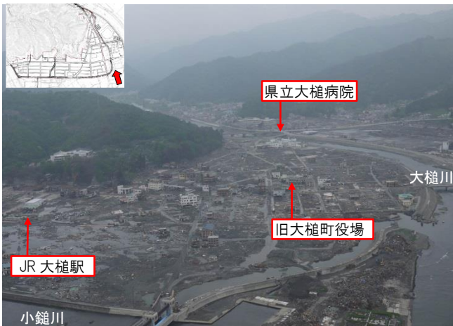
被災した町方地区【町の中心地は、役場も含め壊滅的被害を受け
