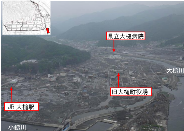
被災した町方地区【町の中心地は、役場も含め壊滅的被害を受けた】
