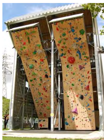
岩手県営運動公園登はん競技場リードA・B壁
