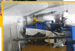
橋桁に必要なPCケーブル(鋼材)を張っている状況
