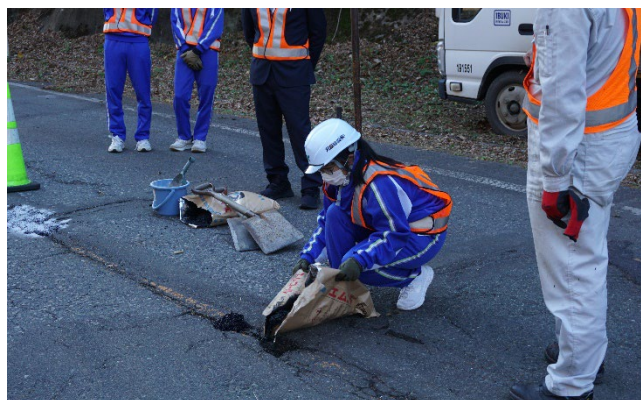
アスファルト舗装の穴埋めを体験 (宮古市立川井中学校)
