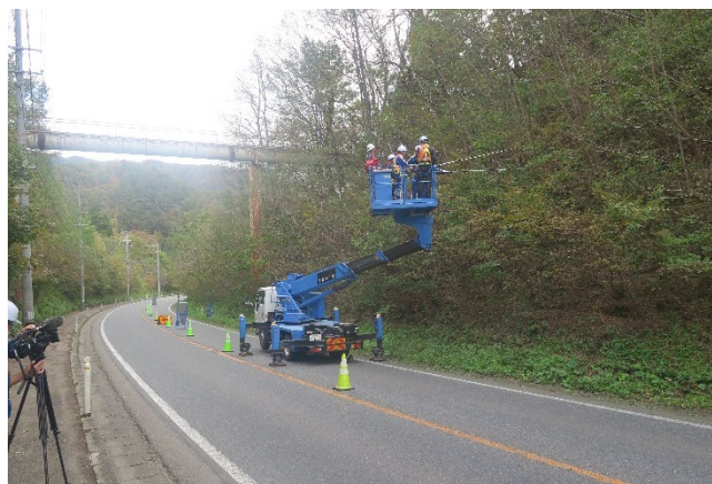
車両通行の支障となっている木の伐採を体験 (宮古市立新里中学校)
