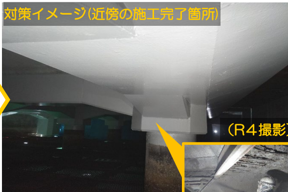
補修材の吹き付け状況イメージ (近傍の施工完了箇所)
