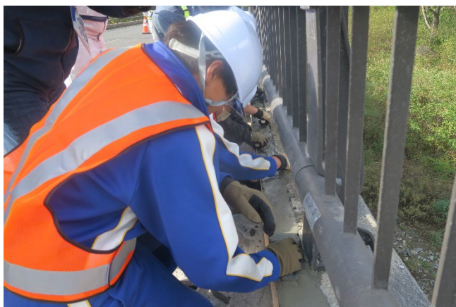
一般国道 106 号明戸橋の断面修復を体験 (宮古市立新里中学校)
