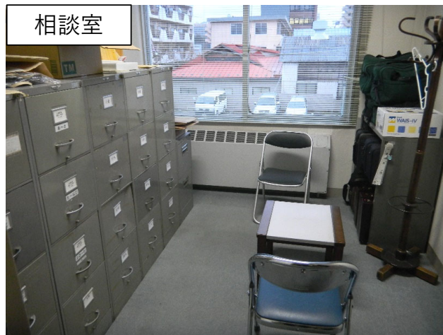
庁内の老朽箇所
