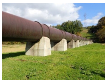
岩洞第二発電所濁川サイフォン
