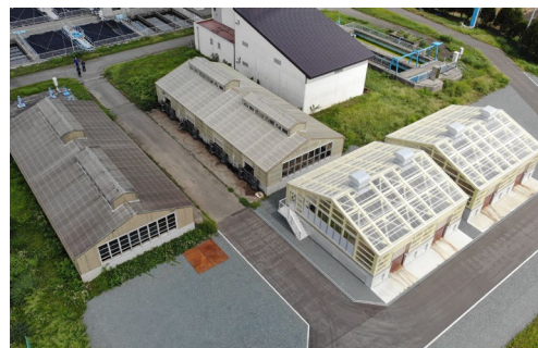
第二浄水場 天日乾燥床
