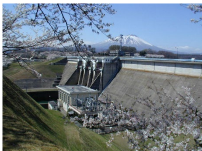
四十四田ダムと四十四田発電所
