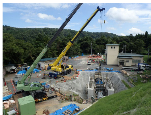
胆沢第二発電所 農業用水放流設備の設置状況
