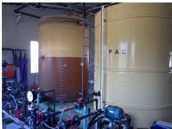
第二浄水場薬品貯留槽
