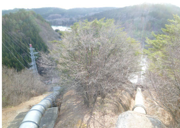
岩洞第二発電所水圧鉄管と 岩手山麓土地改良区農業用水管
