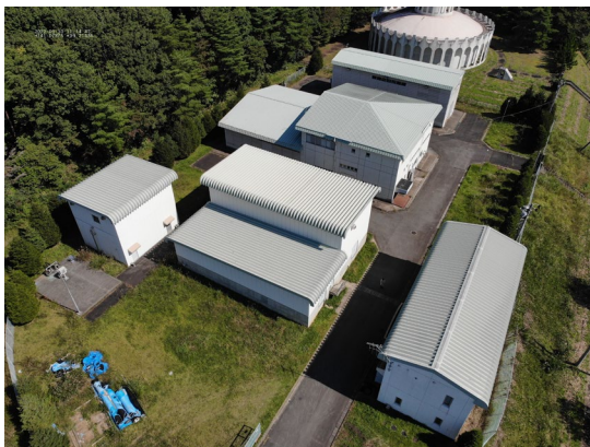
金ヶ崎ろ過施設
