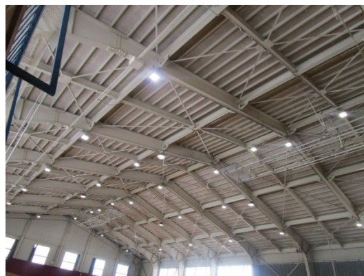
体育館照明LED化(滝沢市)
