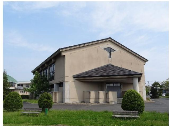
農村環境改善センター外観
