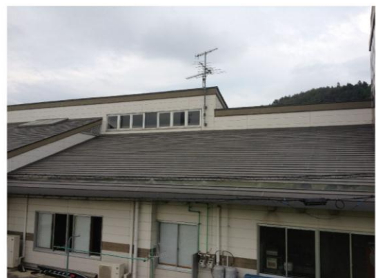
一関東消防署_太陽光設置予定場所
