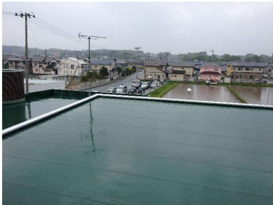
古館公民館 屋上1
