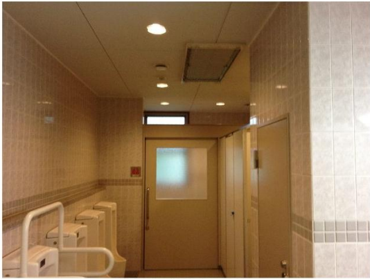
水沢地区センター_トイレ
