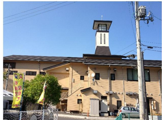
観光交流センター_太陽光設置屋根
