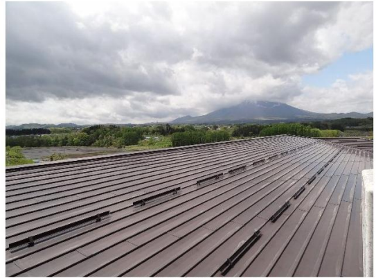
玉山総合事務所屋上2
