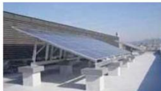
2 台の 5kW 太陽電池アレイが接続箱でまとめられ、パワーコンディショナに接続される。太陽電池面の傾斜角度は 20° にしている。
