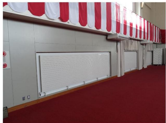
農村環境改善センター多目的ホール4
