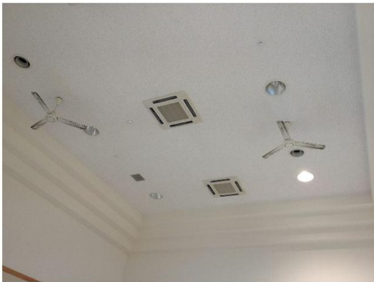
観光交流センター_多目的ホール天井
