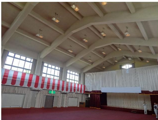
農村環境改善センター多目的ホール1
