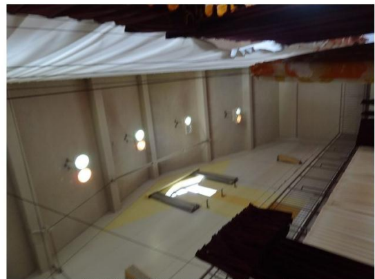
農村環境改善センター多目的ホール2
