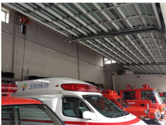
一関東消防署_車庫
