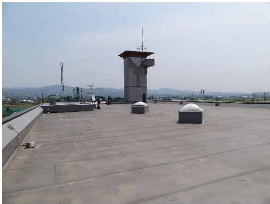
防災コミュニティセンター屋上
