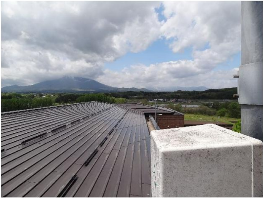
玉山総合事務所屋上1
