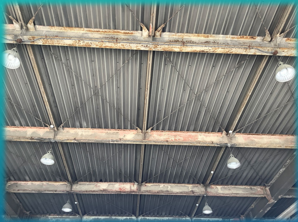
工場内 水銀灯
