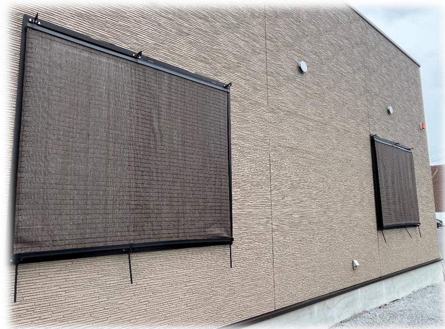
エアコンの冷房を同じ温度に設定しても温度の高い部屋は、その分だけ負荷がかかるため動力を多く消費します。日射防止を設置することで夏場の日差し・室内の気温を和らげることで省エネ効果UP！です。
