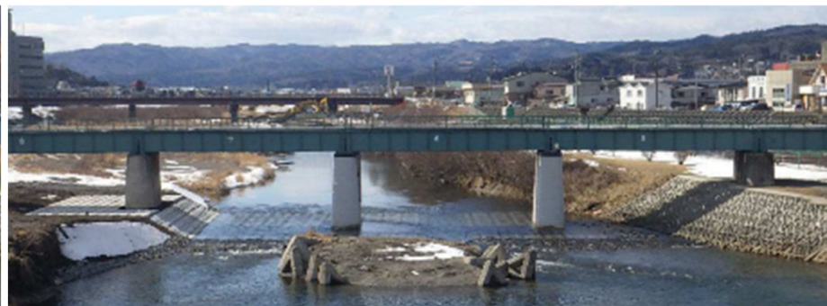
洗掘対策後(久慈川下流側より)
