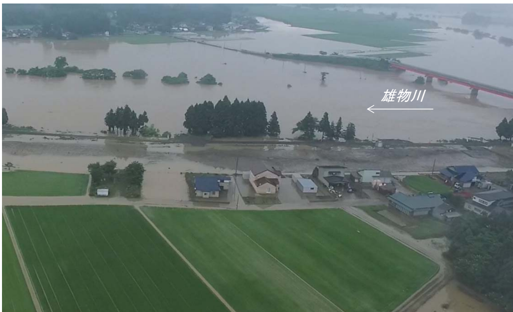
秋田県秋田市新波地区の被害状況（平成29年7月23日撮影）
