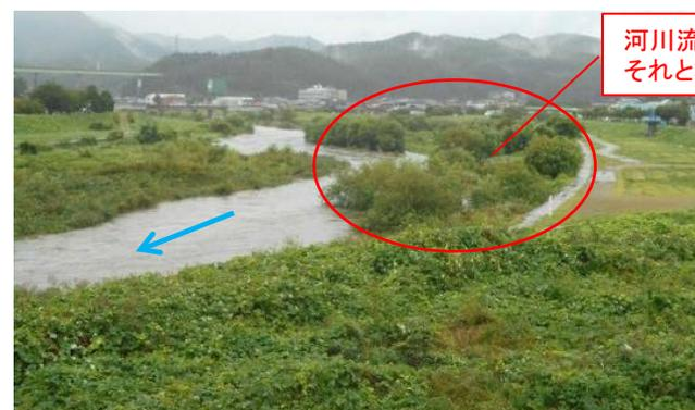
河川流下阻害となる河道堆積土砂の撤去(河道掘削)の推進。
