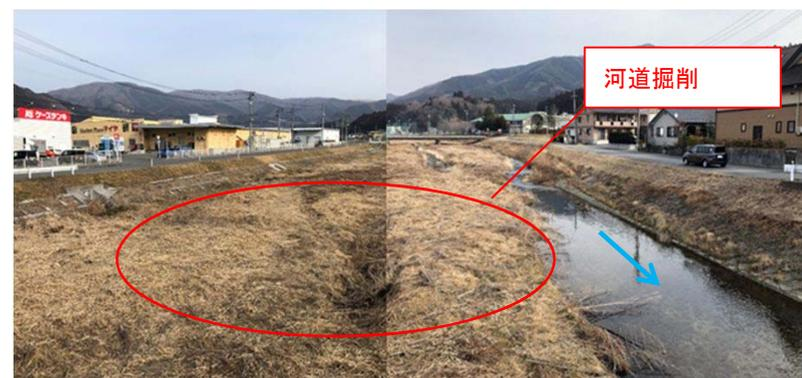
河川流下阻害となる河道堆積土砂の撤去(河道掘削)の推進。
