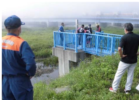
重要水防箇所合同巡視
