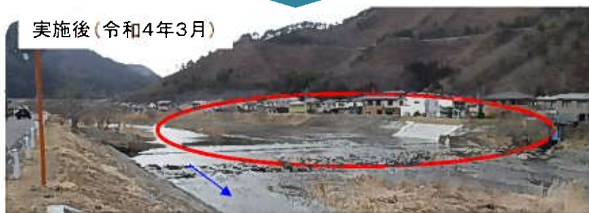
小鍬川小鍬地区 河道掘削・立ち木伐採実施箇所
