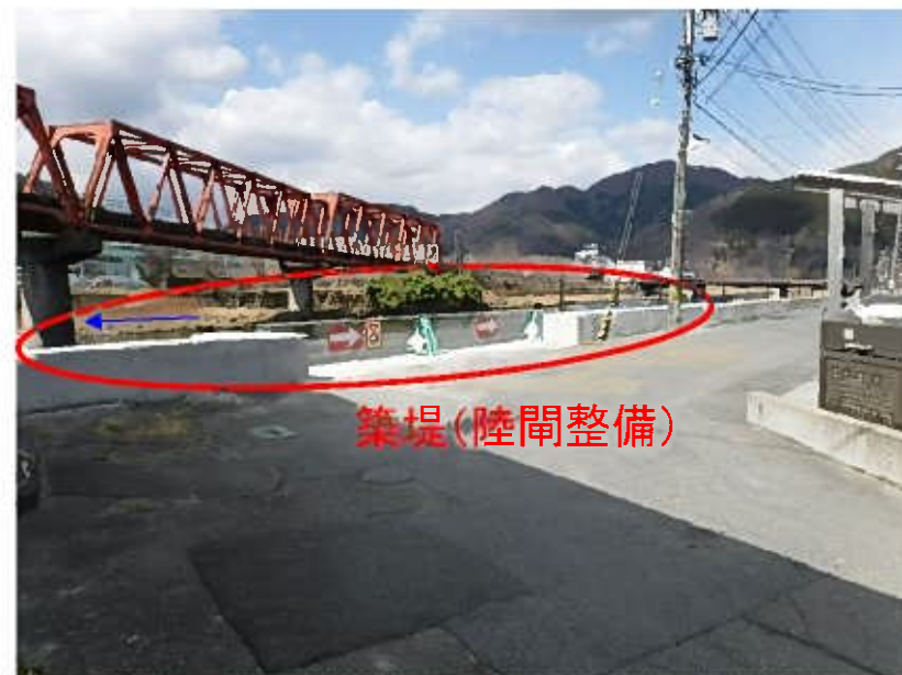
甲子川大渡地区 河川改修実施箇所(令和3年11月から実施中)
