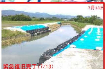
緊急復旧完了(7/13)
