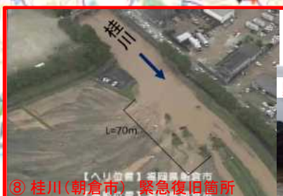
⑧ 桂川(朝倉市) 緊急復旧箇所
