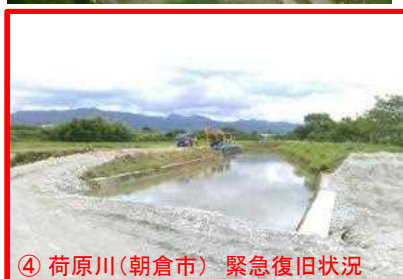
④ 荷原川(朝倉市) 緊急復旧状況
