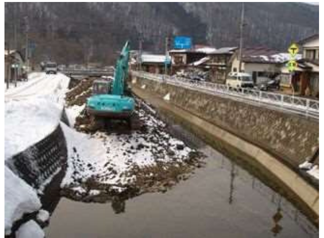
河道掘削状況
