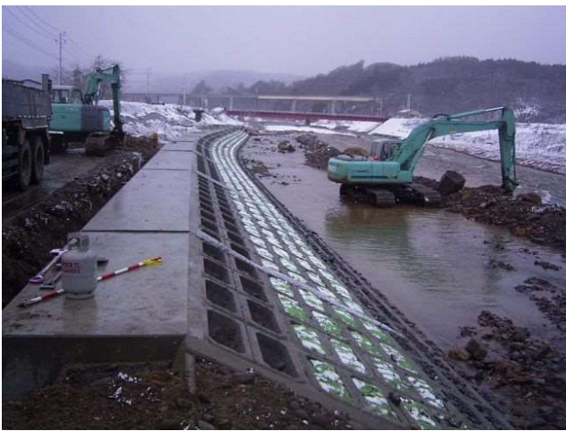
災害復旧工事の状況
