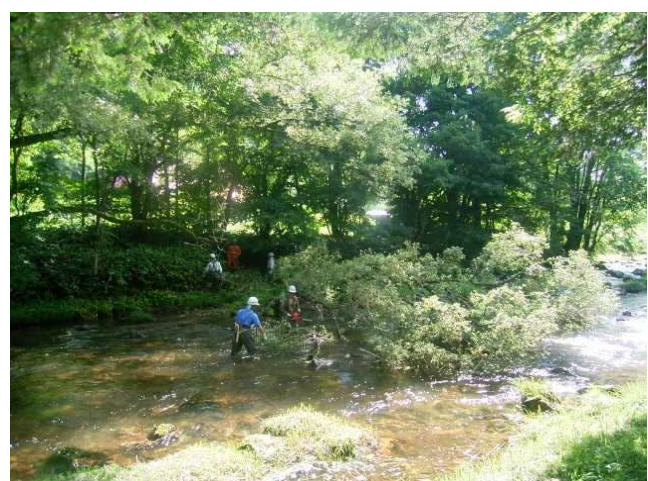
立ち木伐採・除草の状況
