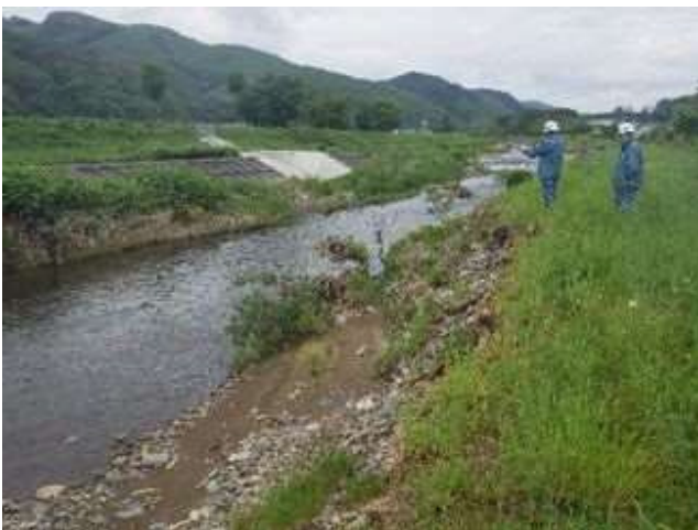
立ち木伐採・除草の状況
