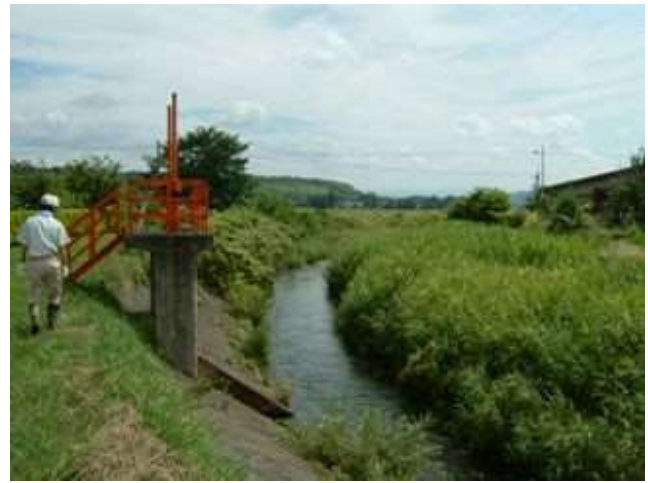
排水施設等の点検状況
