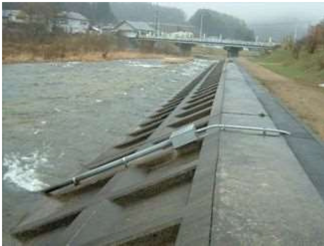
水位計設置状況
