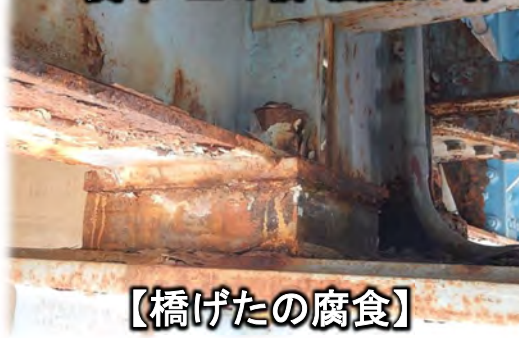
一関市 上の橋（国道284号）
