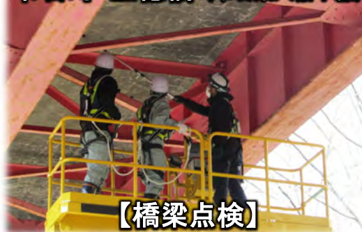
雫石町 正徳橋（雫石東八幡平線）
