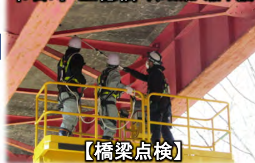
雫石町 正徳橋（雫石東八幡平線）
