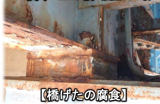
一関市 上の橋（国道284号）
