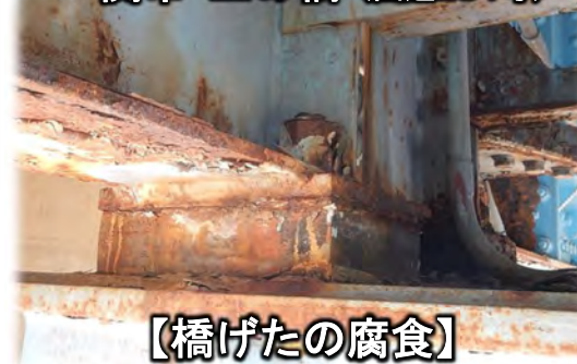
一関市 上の橋 (国道284号)
