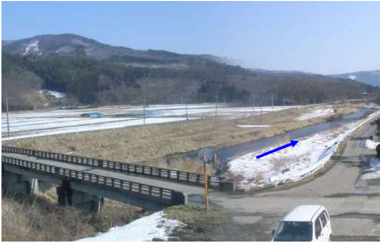
【写真①】 安居台橋下流
