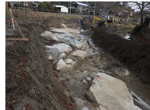
硬岩の出現状況
