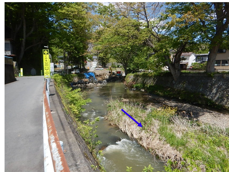
【写真④】四日町橋上流（未着手）
