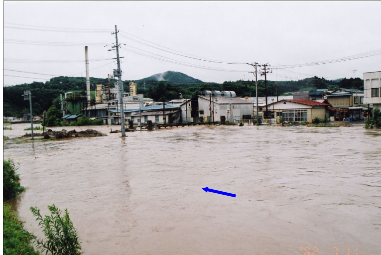
【写真① 千厩川出水状況（H14年7月台風6号）】
