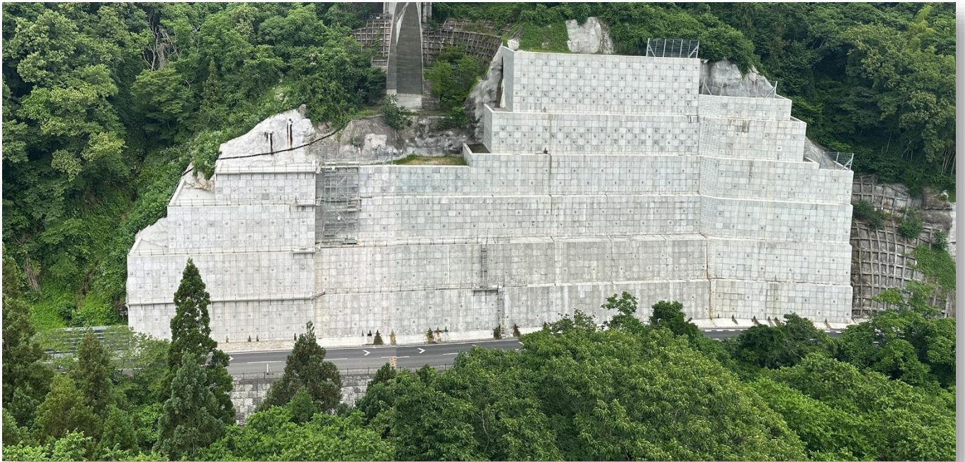
主要地方道水沢米里線 館山法面对策工事
