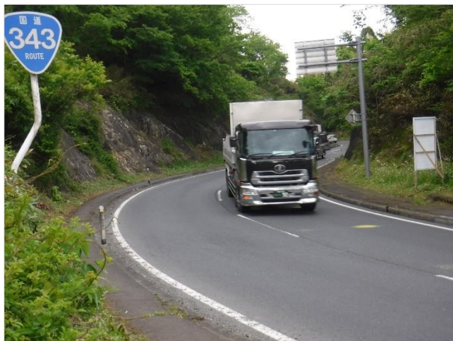
線形不良箇所
