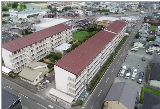
改修を終えた県営内匠田アパート
