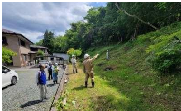
土砂災害危険箇所点検パトロール
