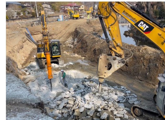
硬岩の掘削状況(ビッガー工法)
