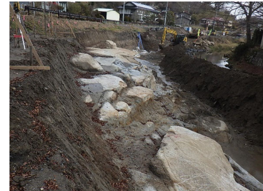
硬岩の出現状況
