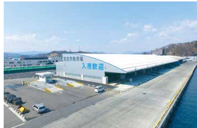
宮古市魚市場の改修 高度衛生管理型魚市場(平成31年3月完成)
