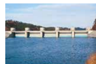
鶴住居川水門(令和4年1月16日自動閉鎖システム稼働による閉鎖状況)
