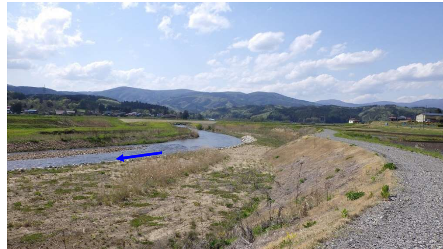
【写真④】 10K250付近 ※一部河道掘削未了
