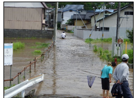
▲令和4年8月3日撮影 一戸町向町浸水状況(馬淵川左岸)
