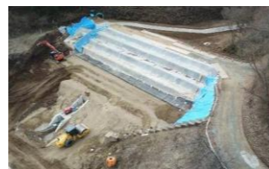
▲ため池の防災工事(奥州市)
