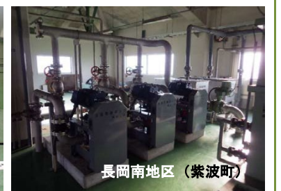
【農業集落排水施設のほつ気攪拌装置、汚泥引抜ポンプ】
