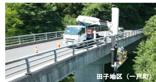
【農道橋の劣化調査】
