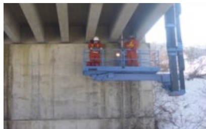
【個別施設計画策定のための農道橋点検】
