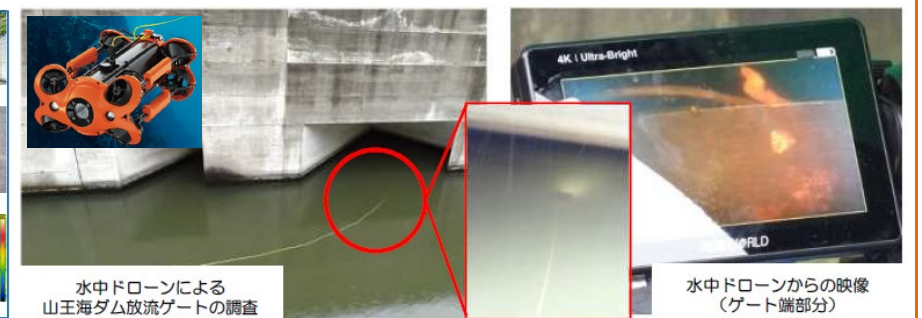
【水中ドローンを活用した施設点検】
