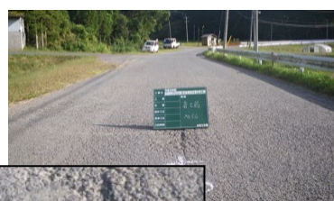
【農道の保全対策前】
