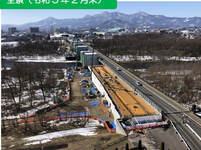
張出し架設工 施工状況（P2橋脚）
