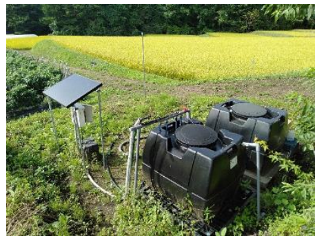
写真3.ソーラーパルサー-Eの設置状況
