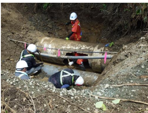
【パイプラインの突発事故による破損・漏水】
