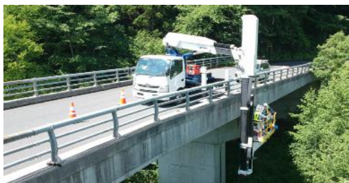
【農道橋の劣化調査】
