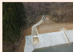
堤体法面の改修
