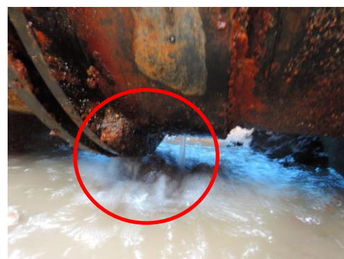
【パイプラインの突発事故による破損・漏水】
