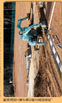
新築予定工事現場 県立高田高校
