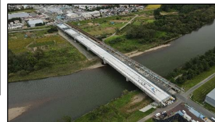
地域連携道路整備事業（徳田橋）
