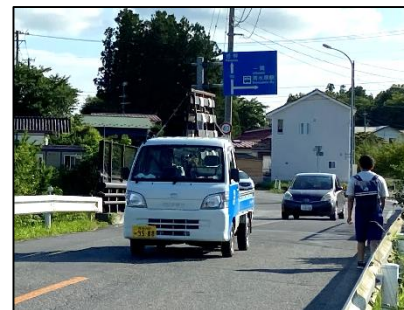
通学路等への歩道設置 若柳花泉線 涌津地区（一関市）
