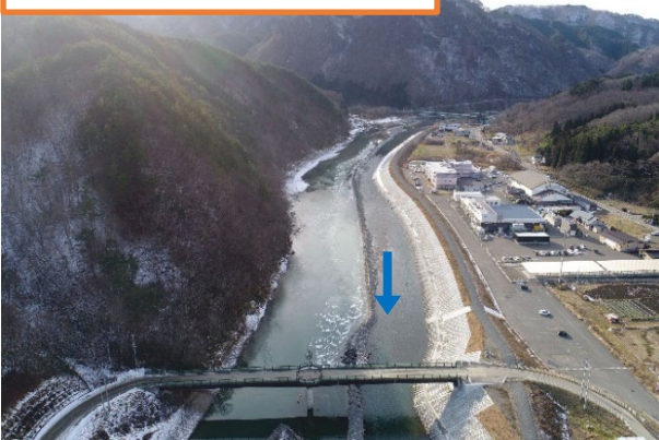
ふれあい橋上流区間（乙茂工区内）
