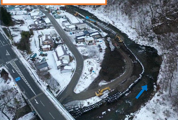
新名目入橋下流区間（門工区）
