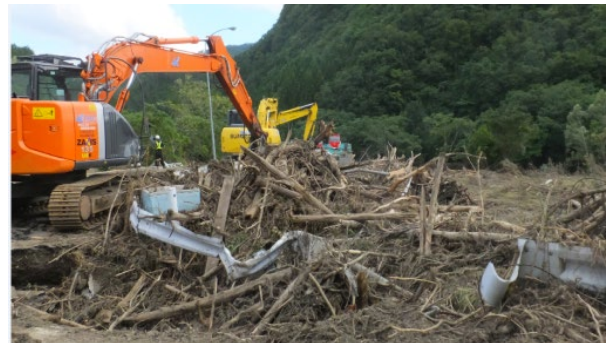
支障となる流木堆積(乙茂地区)
