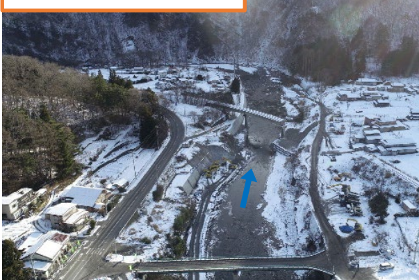
尼額橋下流区間（尼額工区内）
